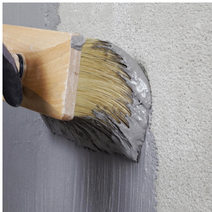
Warstwa kontaktowa nakładana pędzlem.
