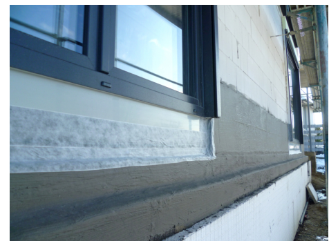
Uszczelnienie stolarki okiennej przy zastosowaniu PCI Barraseal ® Turbo oraz taśm uszczelniających PCI Pecitape ® .
