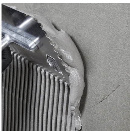
PCI Barraseal® Turbo nakładać w minimum dwóch warstwach. W celu kontroli grubości warstwy materiał można nałożyć pacą zębatą, a następnie wygładzić.
