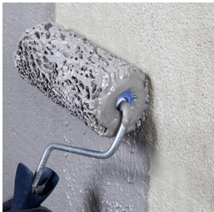
Warstwa kontaktowa nakładana wałkiem
